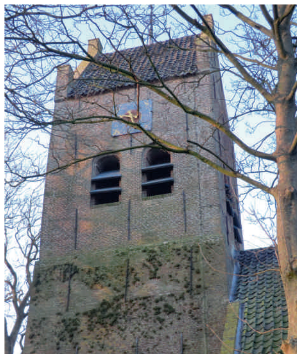
Foto 3 Muurvarens bij -4 graden op de toren in Allingawier
