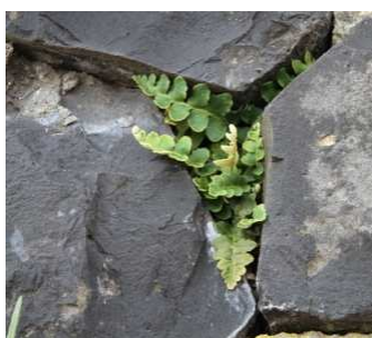
Schubvaren (Stenen Hoofd, A'dam)
